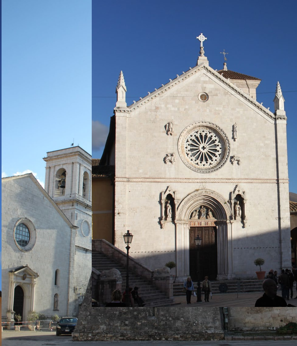
Norcia (16/10/2016) Dommages limités et exemples de dispositions constructives et d'urbanisme Règlements pour la reconstruction en 1859 (puis 1979 et 1997)
