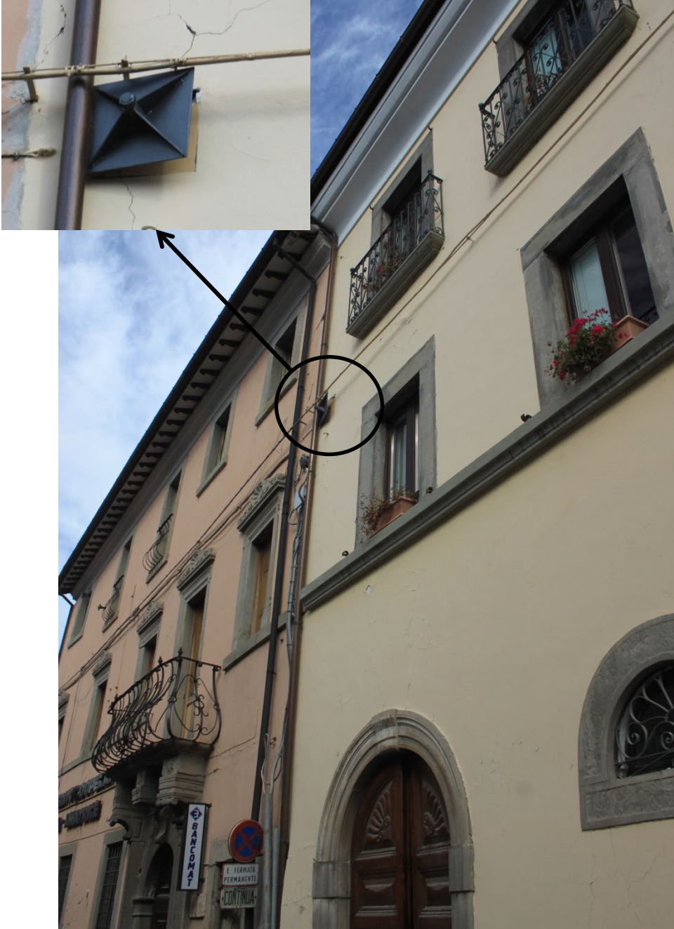
Bâtiment en maçonnerie R+2 ayant subi un confortement sismique (Amatrice - Corso Umberto)
