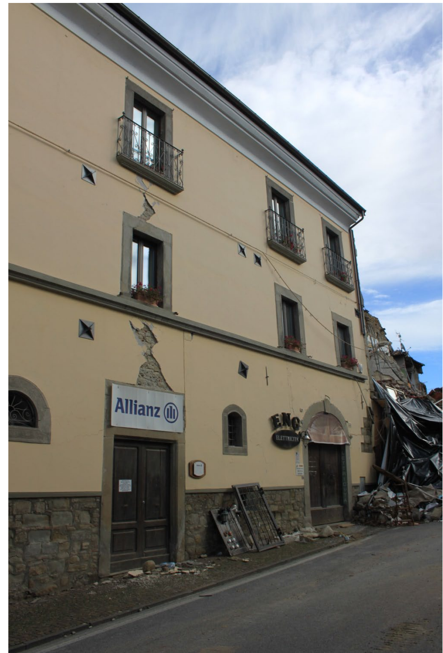
Bâtiment en maçonnerie R+2 ayant subi un confortement sismique (Amatrice - Corso Umberto)
