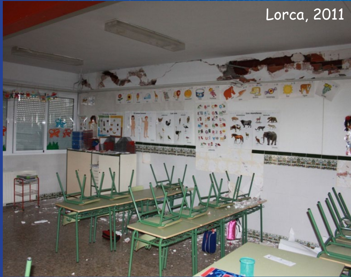
Rupture de la maçonnerie et décollément des carrelages dans une école primaire (structure métallique)
